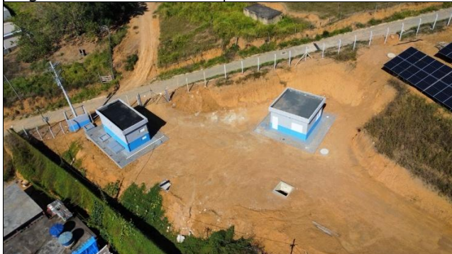
Figura 3 – Casa da Blindada e Sala de O&M
